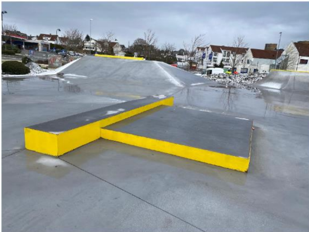
NY betongpark (lagd av Betongpark AS) desember 2023 (den lange delen på bildet er for lav, må ha en høyde på 10 cm til.)
